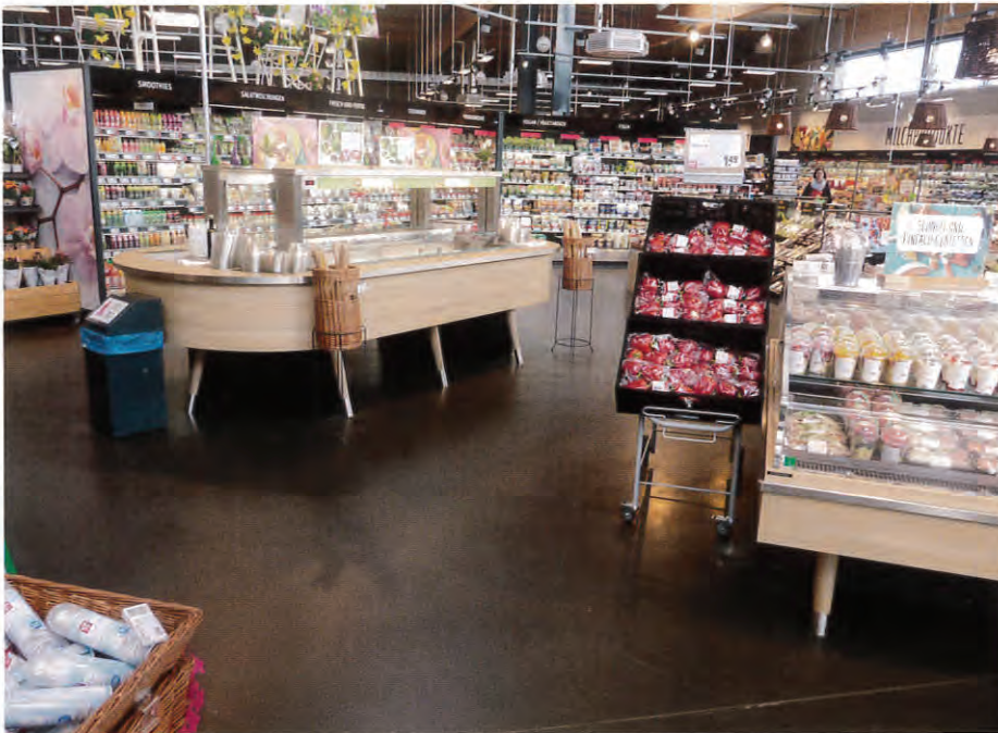
Fugenlose Fläche im neu gebauten Rewe-Markt in Lehrte: Das »Ultratop«-System von Mapei bietet neben der Funktionalität auch optisch den passenden Fußboden für das »Green Building«.
